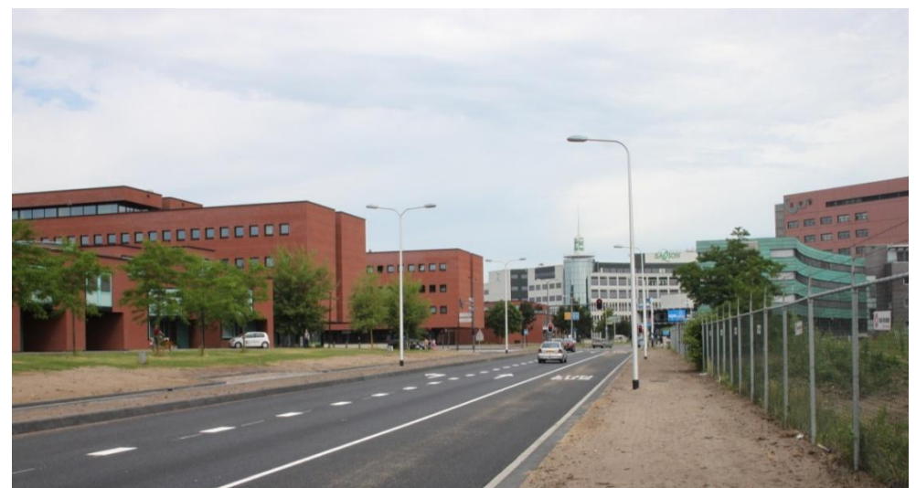
Bestaande situatie: woningen en poortgebouwen van Botta
