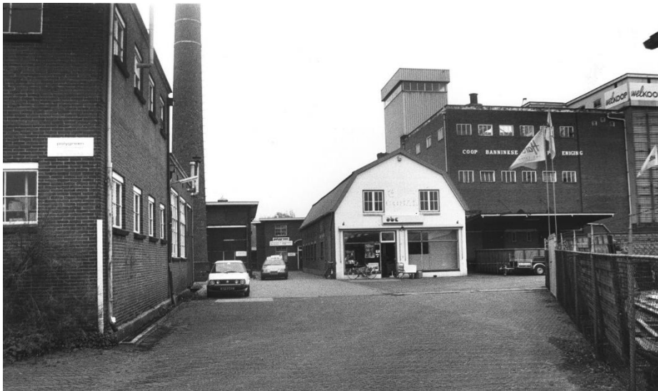
Zicht op de schoorsteen, winkel, silo en maalderij coöperatie. De gebouwen rechts op de foto zijn inmiddels gesloopt.
