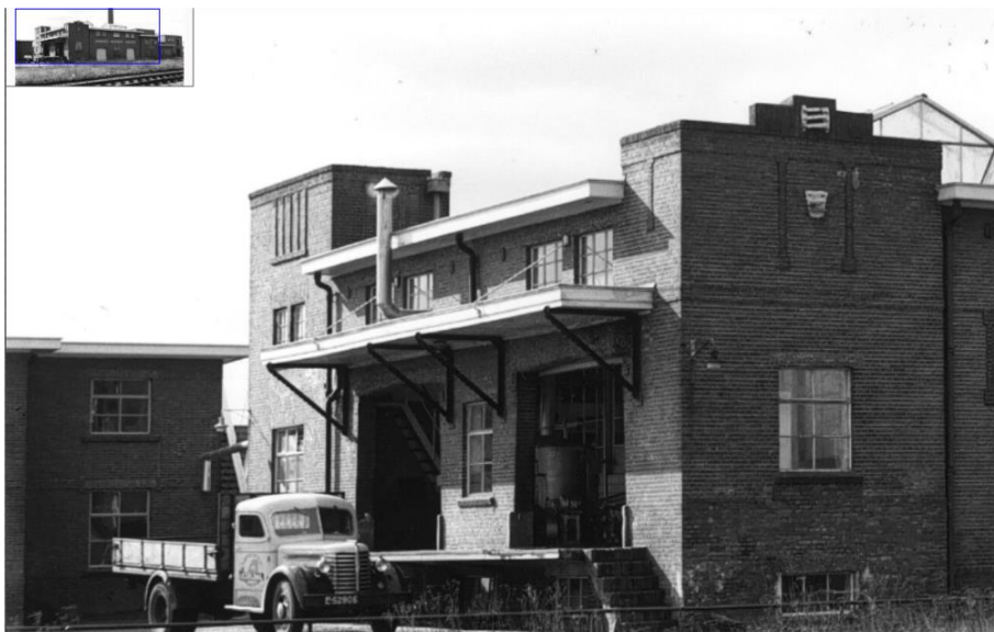
De hoogteaccenten op het dak zijn niet meer aanwezig. Een aanzienlijk deel van het historisch metselwerk gaat tegenwoordig schuil achter eenvoudige, witte tegels. Alle stalen ramen zijn vervangen door kunststof.
