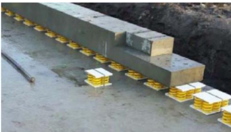
Voorbeeld van een nieuwbouwwoning op trillingsisolatoren
