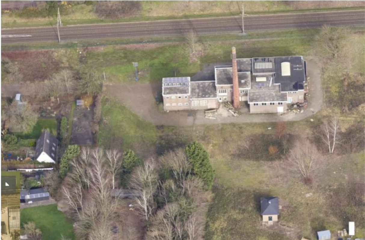
Luchtfoto van het gebied, waarin goed is te zien dat van de oorspronkelijke gebouwen niets meer is overgebleven. Ook de kenmerkende bijbehorende vloeivelden en terreininrichting is niet meer herkenbaar.
