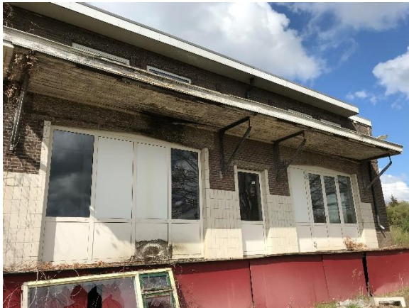
De kunststof puien, later aangebrachte machinaal vervaardigde tegels, het op plaatsen slordig herstelde metselwerk en voegwerk doen de architectuurhistorische waarde van het oudste deel van de fabriek geen goed. De houten luifel en gietijzeren steunberen verkeren thans in zeer slechte staat.
