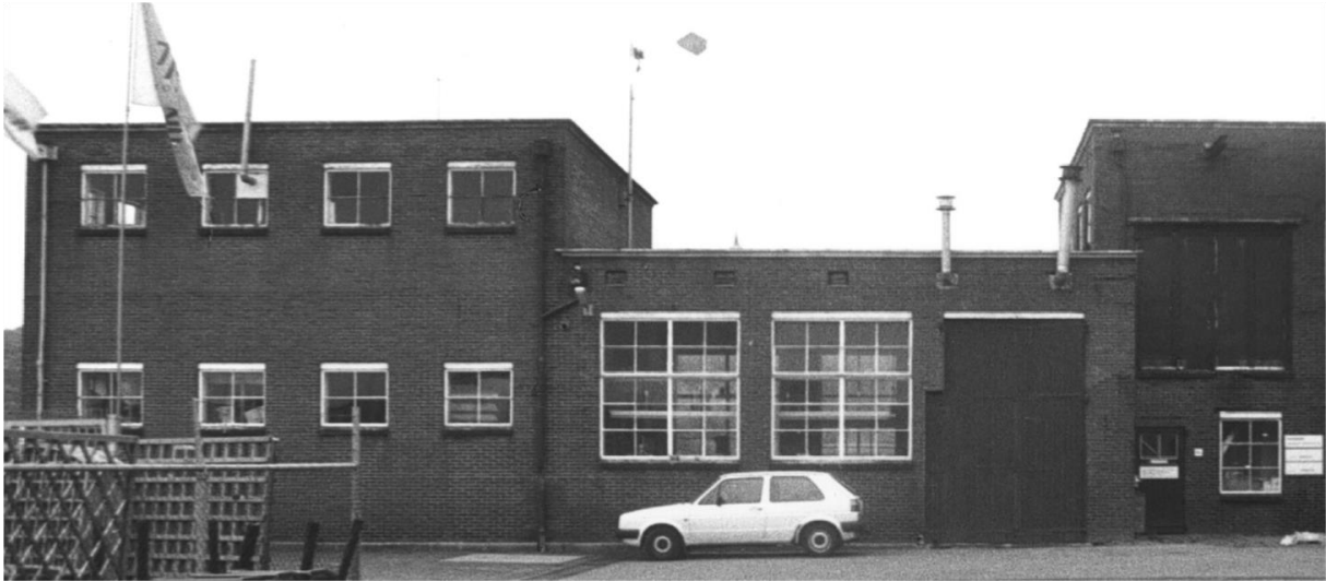
Foto uit 1992 met zicht op de naoorlogse gebouwdelen. Opvallend zijn de toen nog aanwezige stalen ramen, thans uitgevoerd in kunststof.
