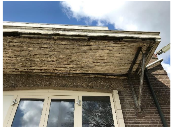
De kunststof puien, later aangebrachte machinaal vervaardigde tegels, het op plaatsen slordig herstelde metselwerk en voegwerk doen de architectuurhistorische waarde van het oudste deel van de fabriek geen goed. De houten luifel en gietijzeren steunberen verkeren thans in zeer slechte staat.
