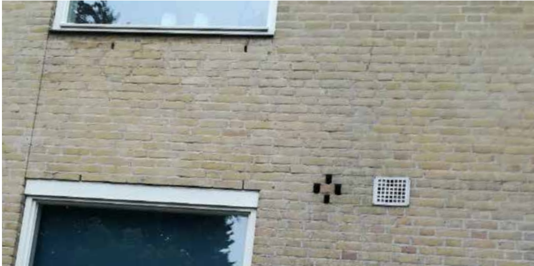
Toegangen tot de spouwmuur in het appartementencomplex.
