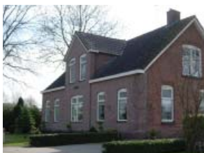
Verbouwde voormalige boerderij langs Meeleweg.
