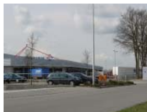
Grootchalig bedrijfsgebouw van het transportbedrijf.
