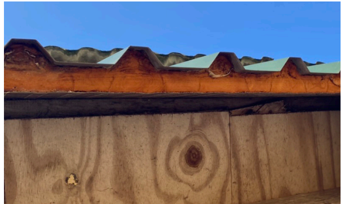
Afbeelding 8. Afwerking overgang damwand en stenenmuur geen invliegopeningen waargenomen
