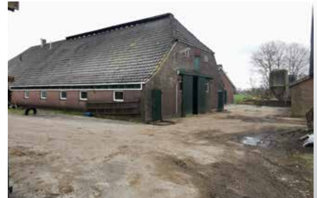
Figuur 14 Achterzijde woonboerderij, zuidkant.
