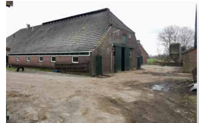
Figuur 14 Achterzijde woonboerderij, zuidkant.
