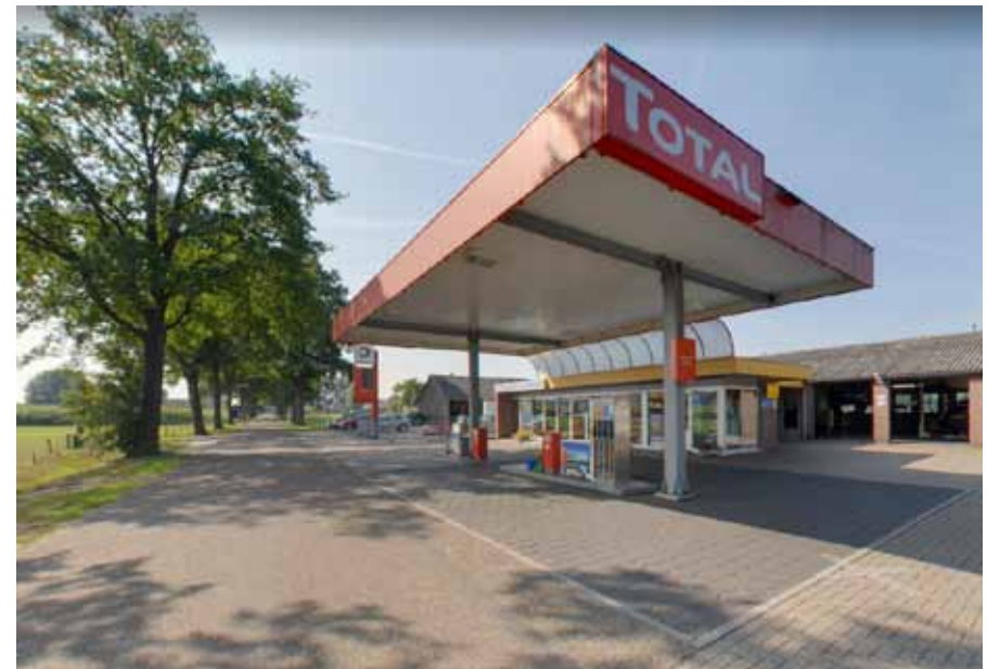
3. Tankgedeelte Vossersteeg 99 zal worden gesaneerd en gesloopt en er zal sprake zijn van landschappelijke kwaliteitsverbetering.
