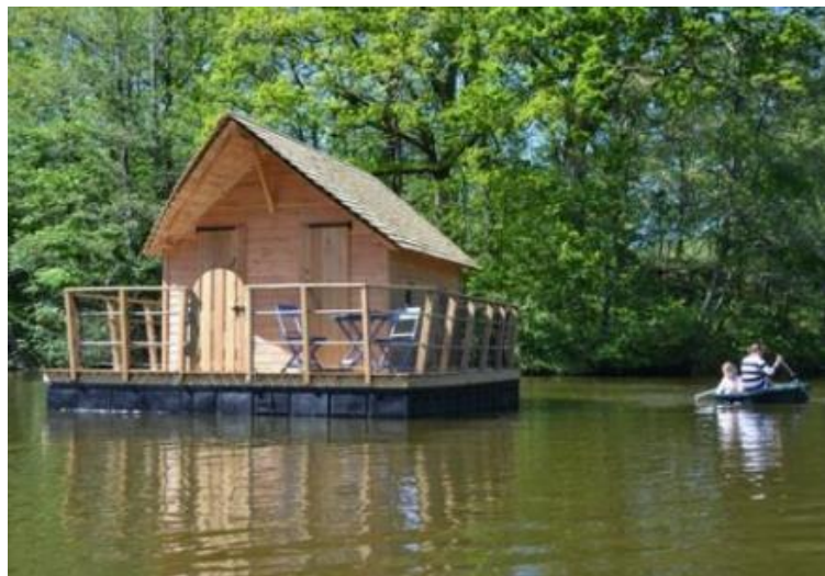
Foto: Het Oversticht
