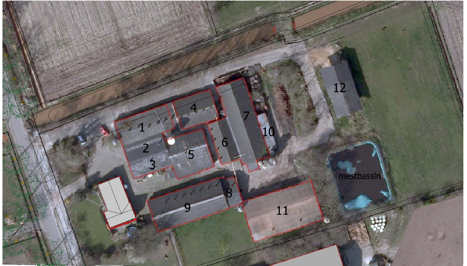
te amoveren bedrijfsgebouwen, mestbassin en terreinverharding
