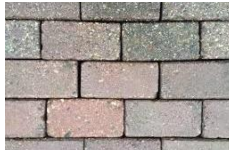
Grindbetonstenen in plaats van betonplaten
