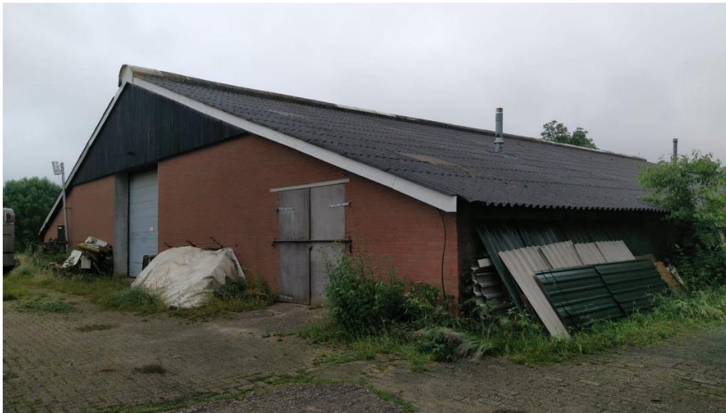
Figuur 3: Beeld van de zuidoostgevel van de ligboxenstal (situatie 30 juni 2021).
