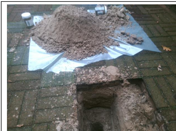
Foto: Inspectiegat A13
