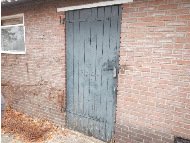
Houten deuren zoals deze bij vervanging kopiëren, zodat uitstraling blijft.
