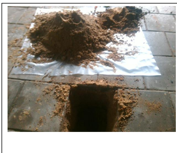
Foto: Inspectiegat A06
