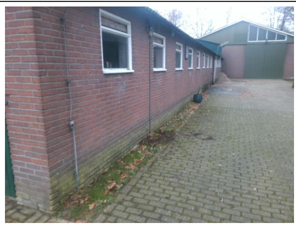
Foto: Inspectiegat C02
