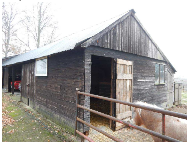
Wanden zijn destijds met voorhanden aanwezig houtwerk afgewerkt.
