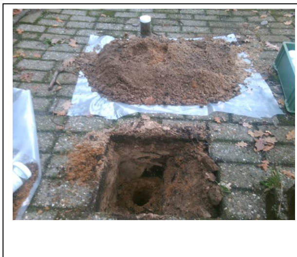
Foto: Inspectiegat A04
