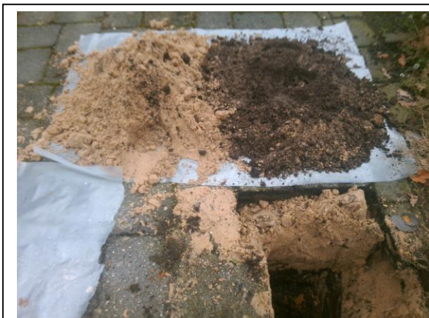
Foto: Inspectiegat A11
