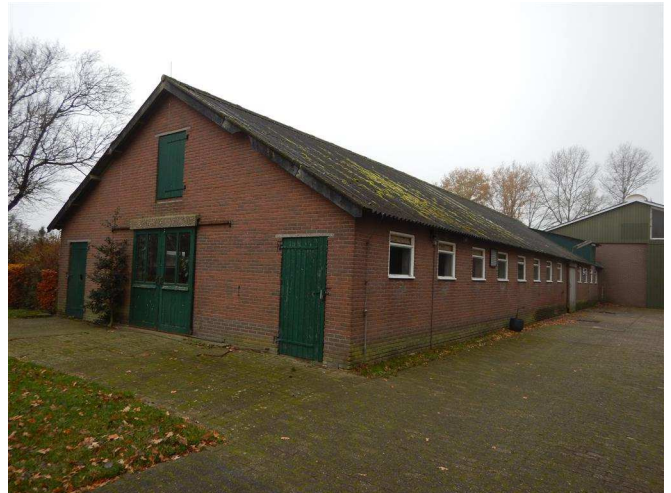
Zijgevel voorzien van betonnen stalramen.
