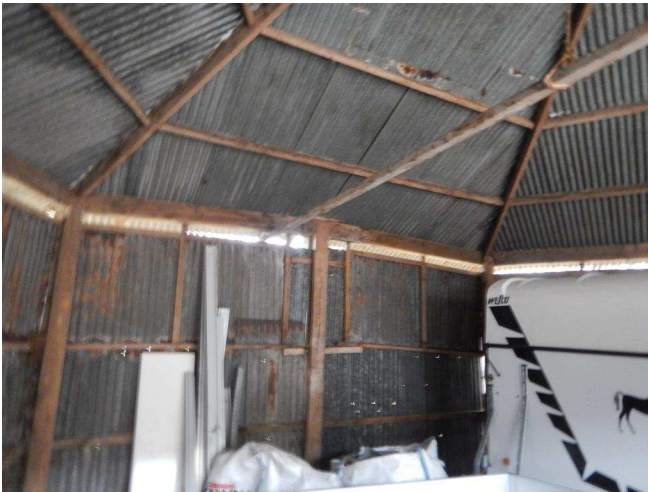
Kap staat op de ondersteuning lanen/liggers zijn aangetast.
