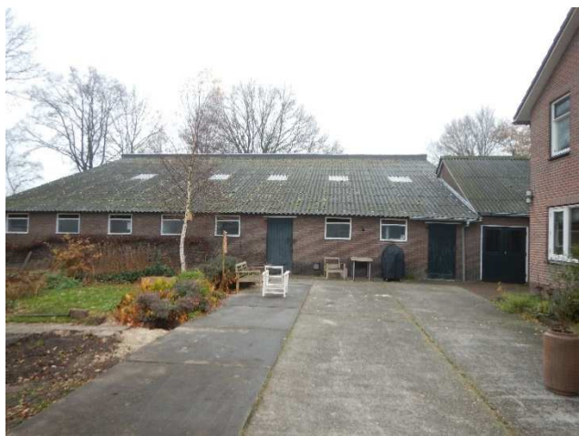
Zuidgevel is de nog originele gevel van de lange schuur/jongveestal.
