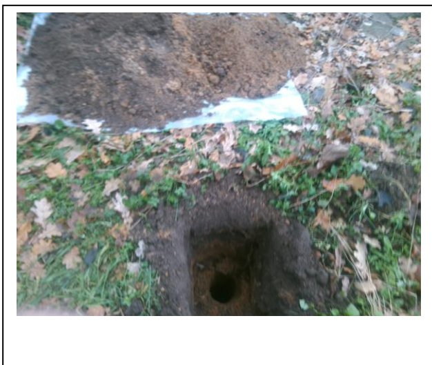
Foto: Inspectiegat A03
