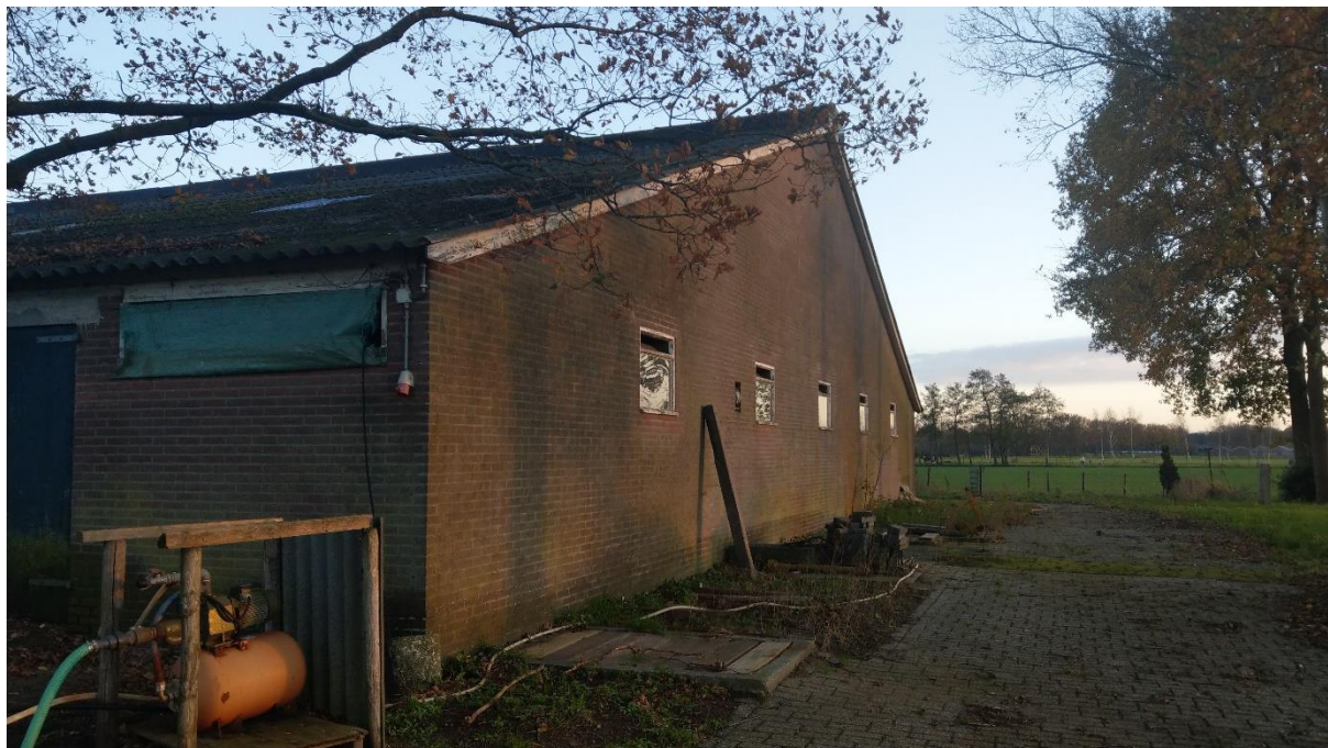
Figuur 2: Beeld van de achterzijde van de ligboxenstal (situatie 20 november 2020).
