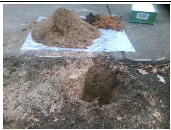
Foto: Inspectiegat A14
