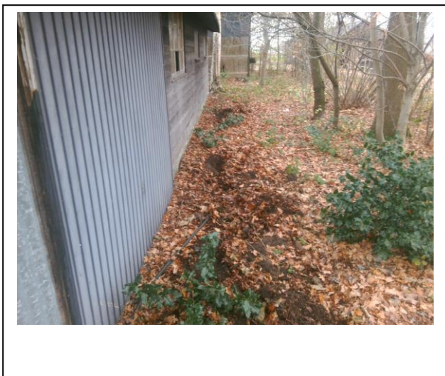
Foto: Inspectiegat B01
