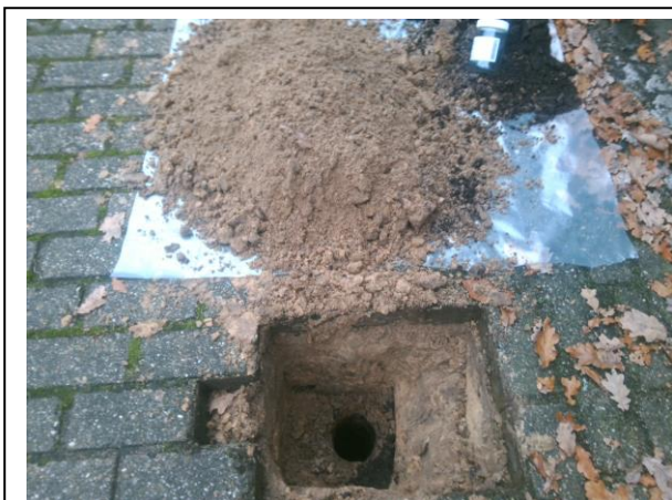
Foto: Inspectiegat A07
