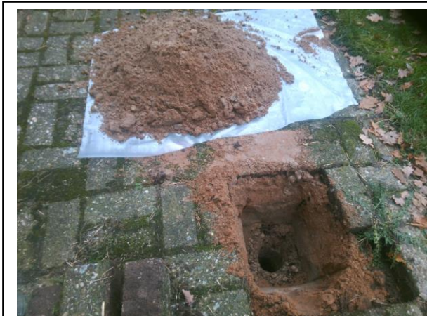
Foto: Inspectiegat A09
