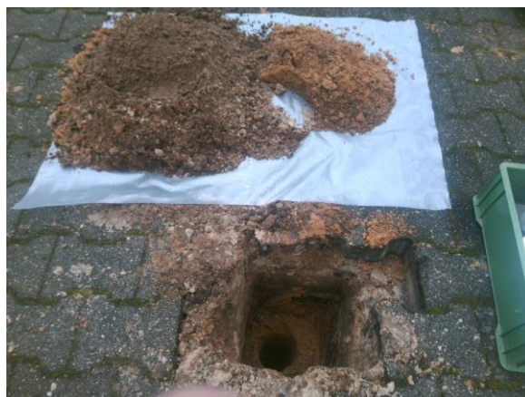
Foto: Inspectiegat A08
