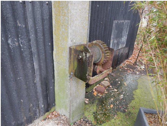
Hijsmechanisme nog aanwezig op betonnen hooibergroede.
