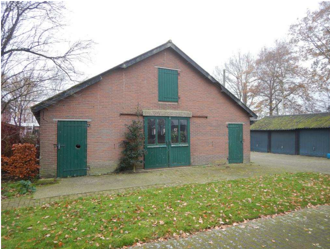
Kopgevel jongveeststal met karakteristieke schuif- en mestdeuren.
