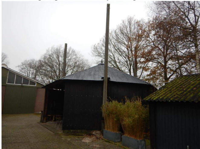
3-Roedige hooiberg met betonnen roeden.
