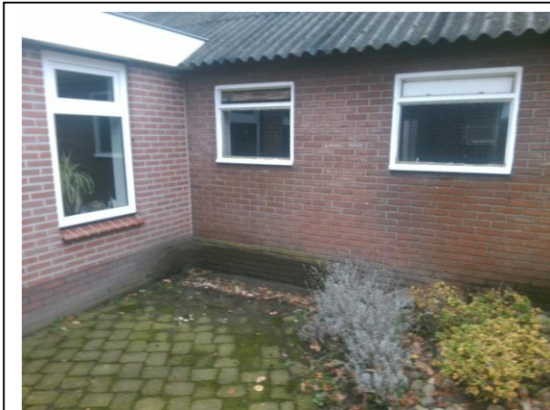
Foto: Inspectiegat C01
