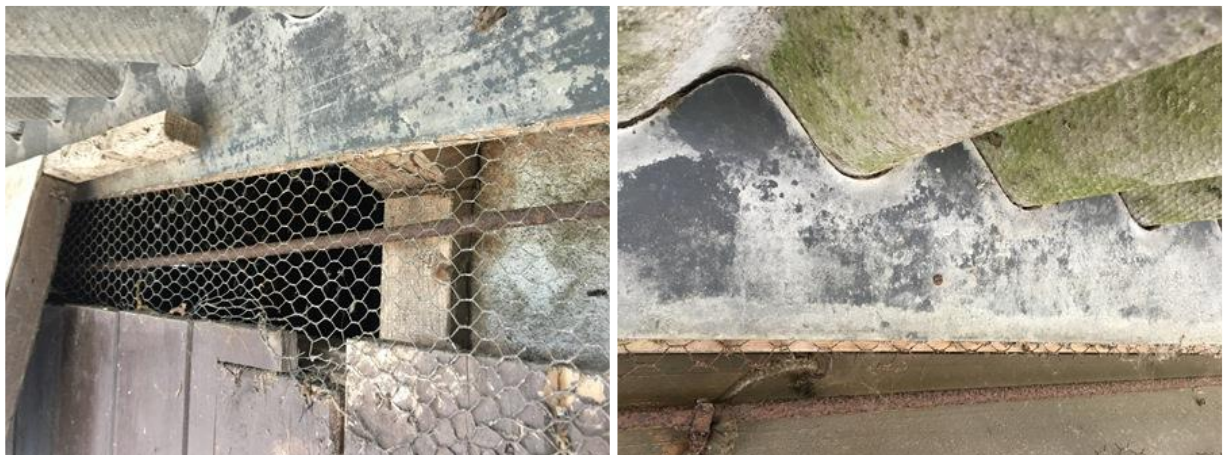
De te slopen stal is afgedicht voor vogels.
