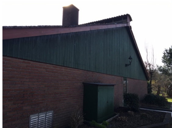
Afbeelding 4. Houtwerk op kopgevel
