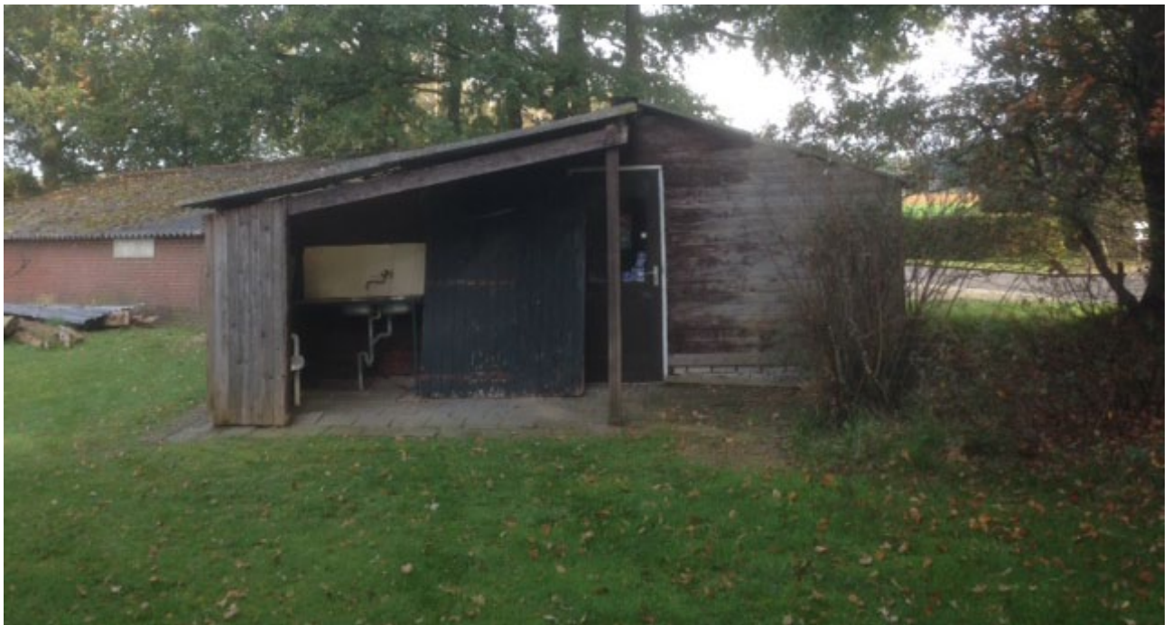
Afbeelding 32. Te slopen schuren aan de Maneweg, omzoomd door opgaand groen
