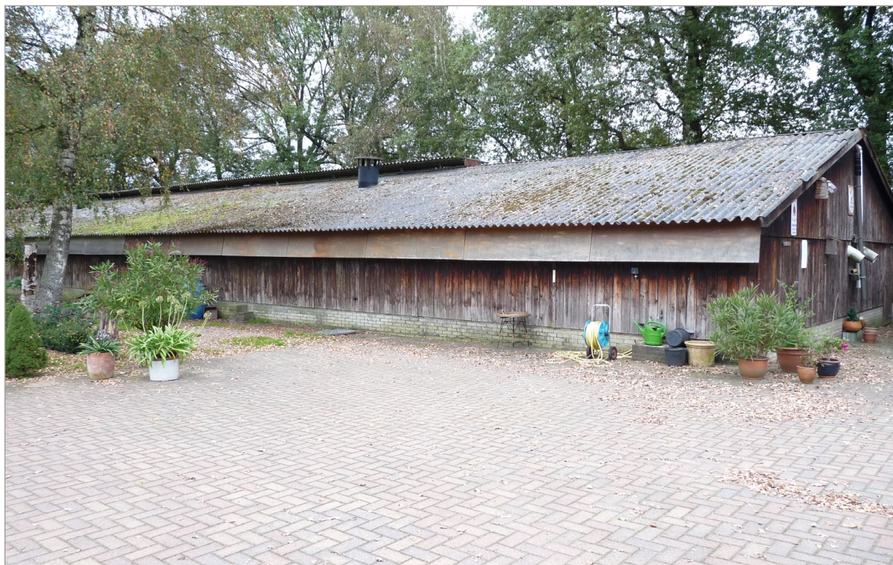
Afbeelding 22. Te slopen kippenschuur
