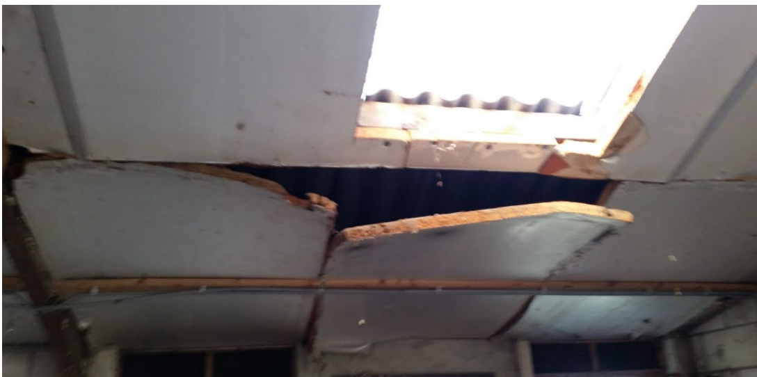
Openingen aan de binnenzijde van de stal
