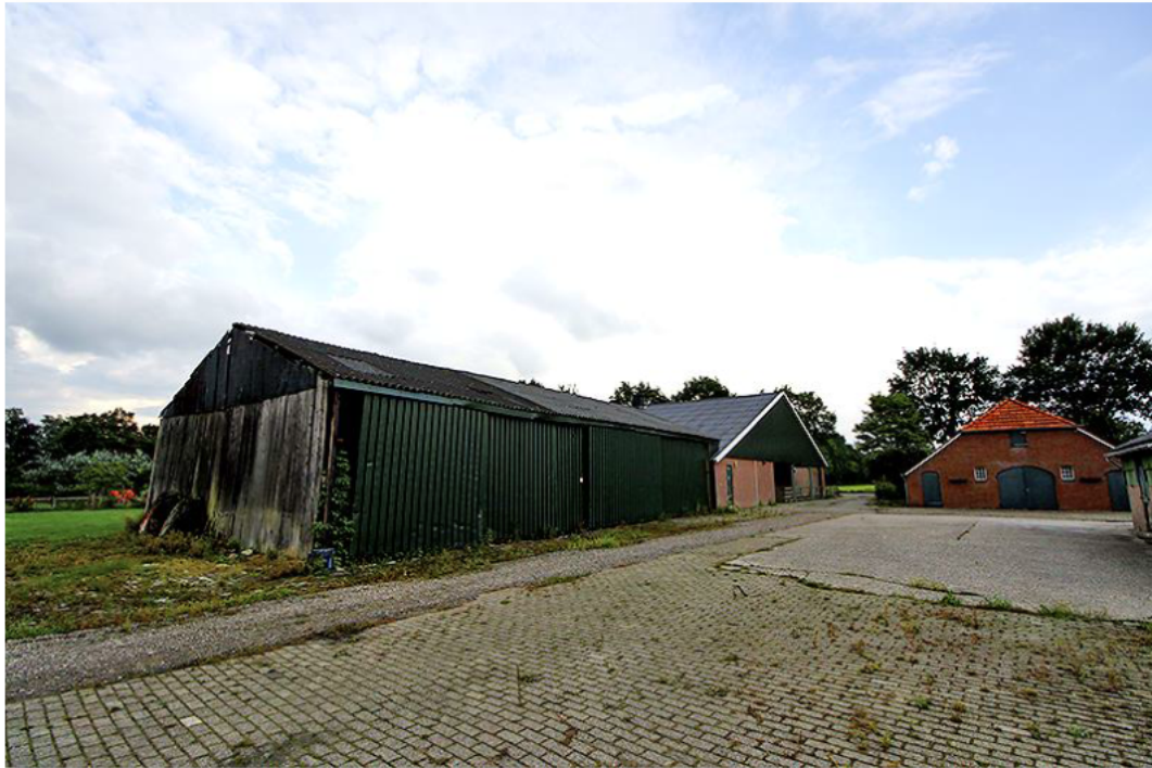
Planlocatie, te slopen varkensstallen
