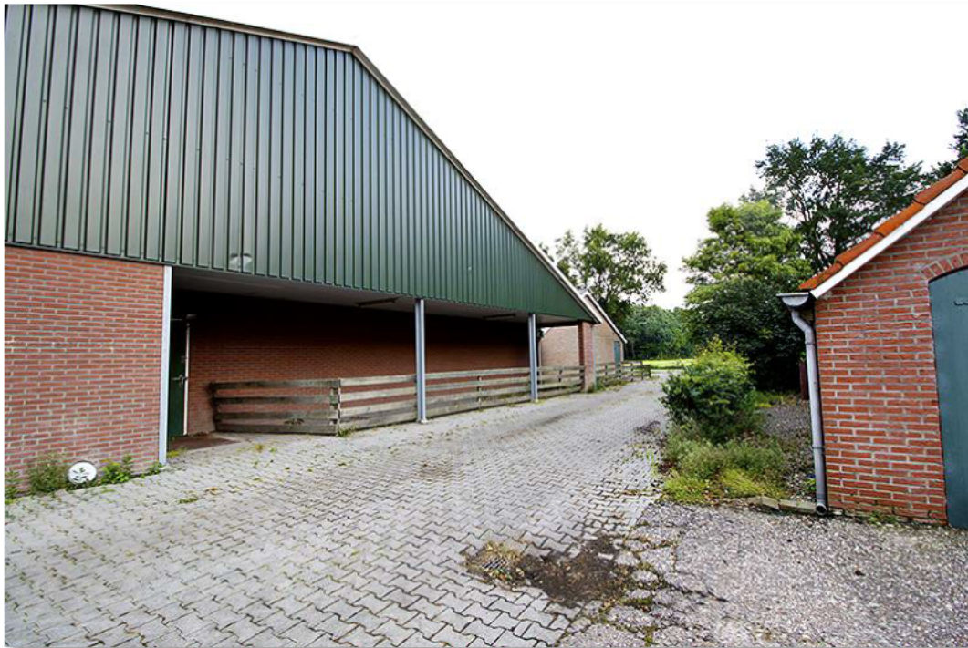
Planlocatie, te slopen varkensstallen
