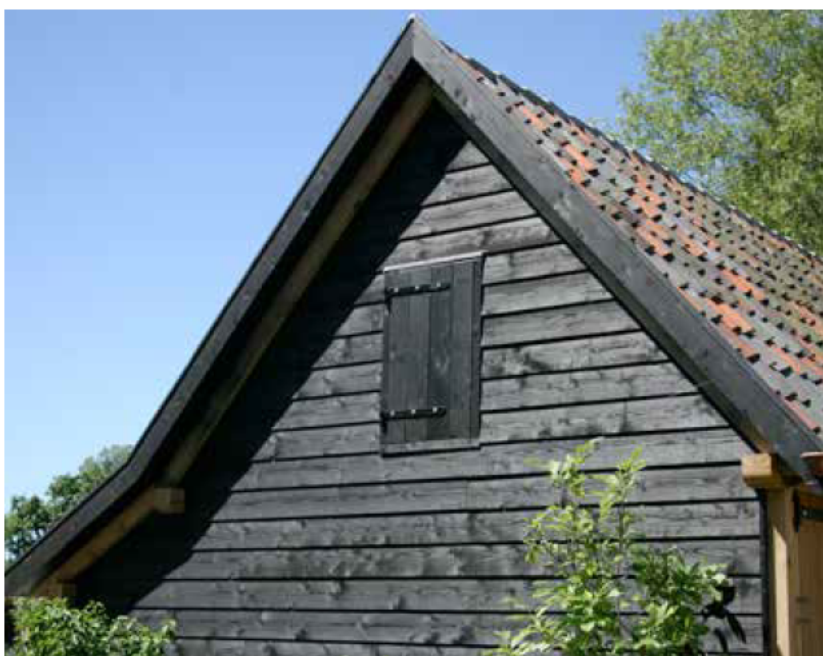
bijgebouw als kapschuur (nieuw of behouden) en bekleed met potdekselwerk
