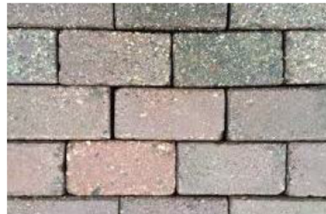
Grindbetonstenen in plaats van betonplaten
