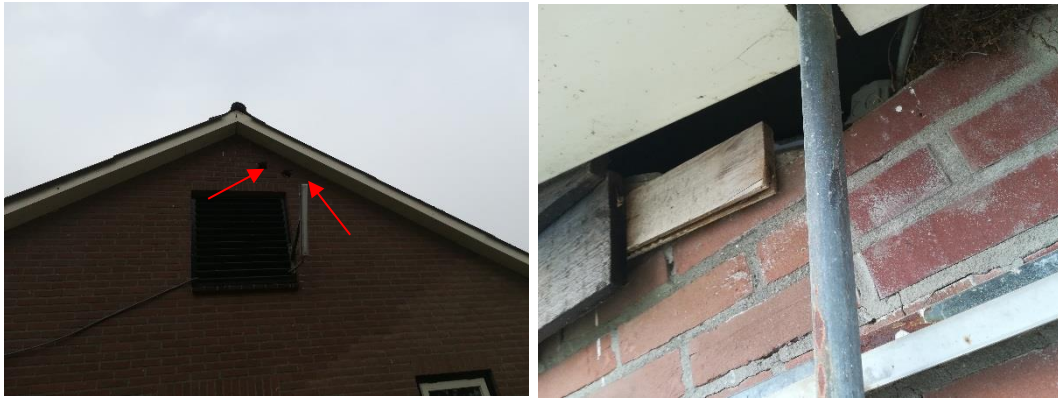
Openingen voor de vleermuis om de spouwmuur te kunnen bereiken (Foto's Laneco)
