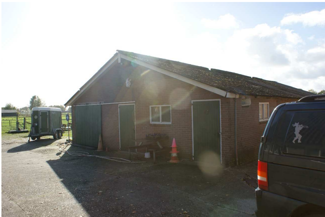
Figuur 2.3. Tweede schuur (achter schuur figuur 2.2) op westelijk terreindeel (wordt gesloopt)
