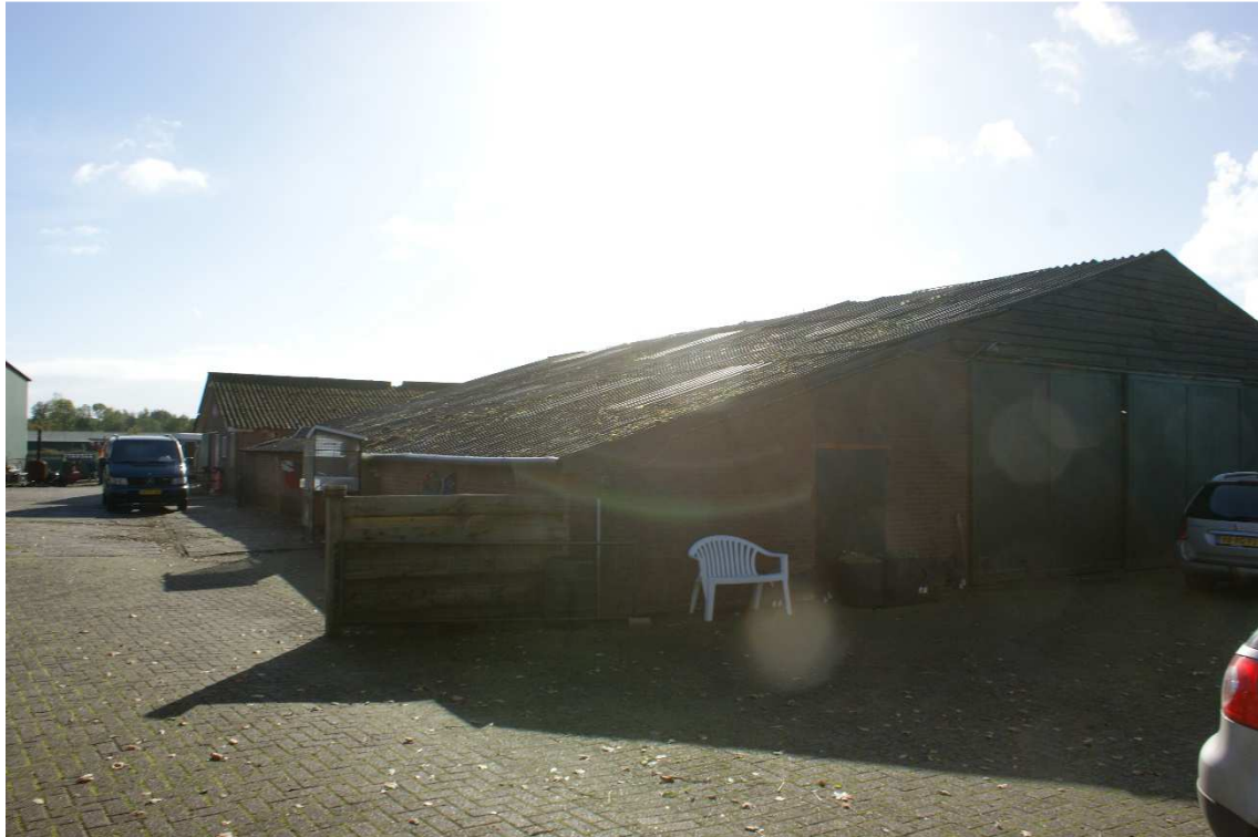
Figuur 2.2. Schuur op westelijk terreindeel, gezien vanaf straatzijde (wordt gesloopt)
