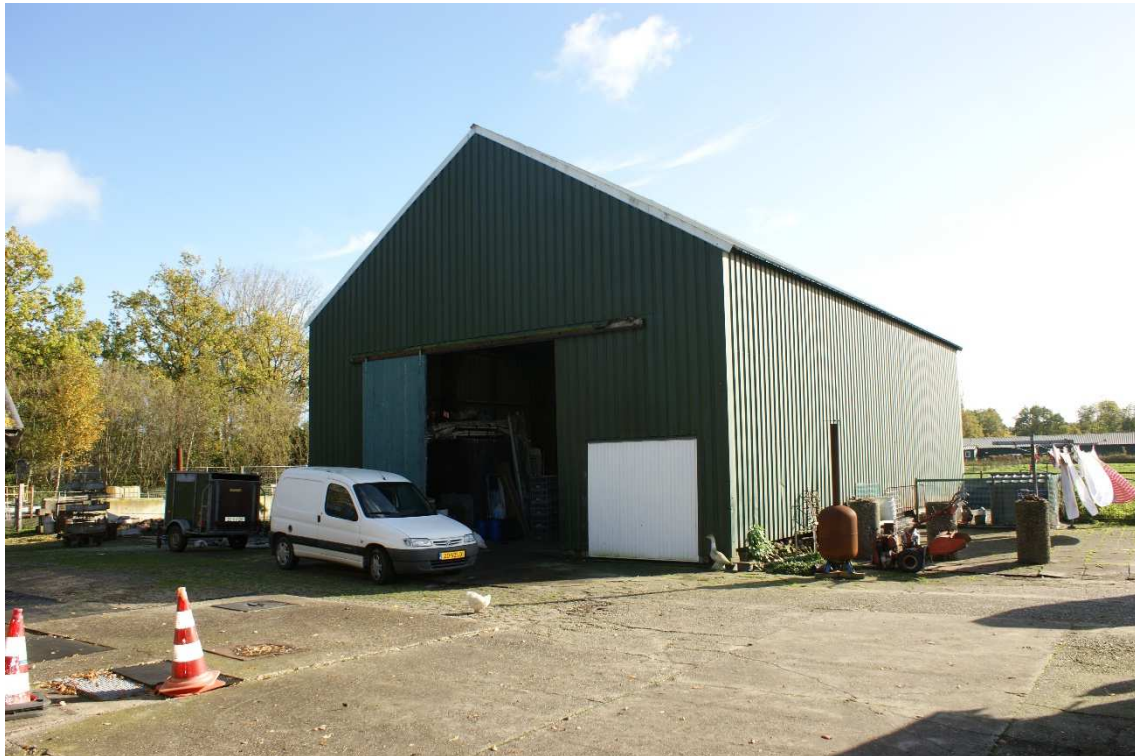
Figuur 2.4. Damwandloods, met daarin kerkuilenkast (wordt gesloopt)
