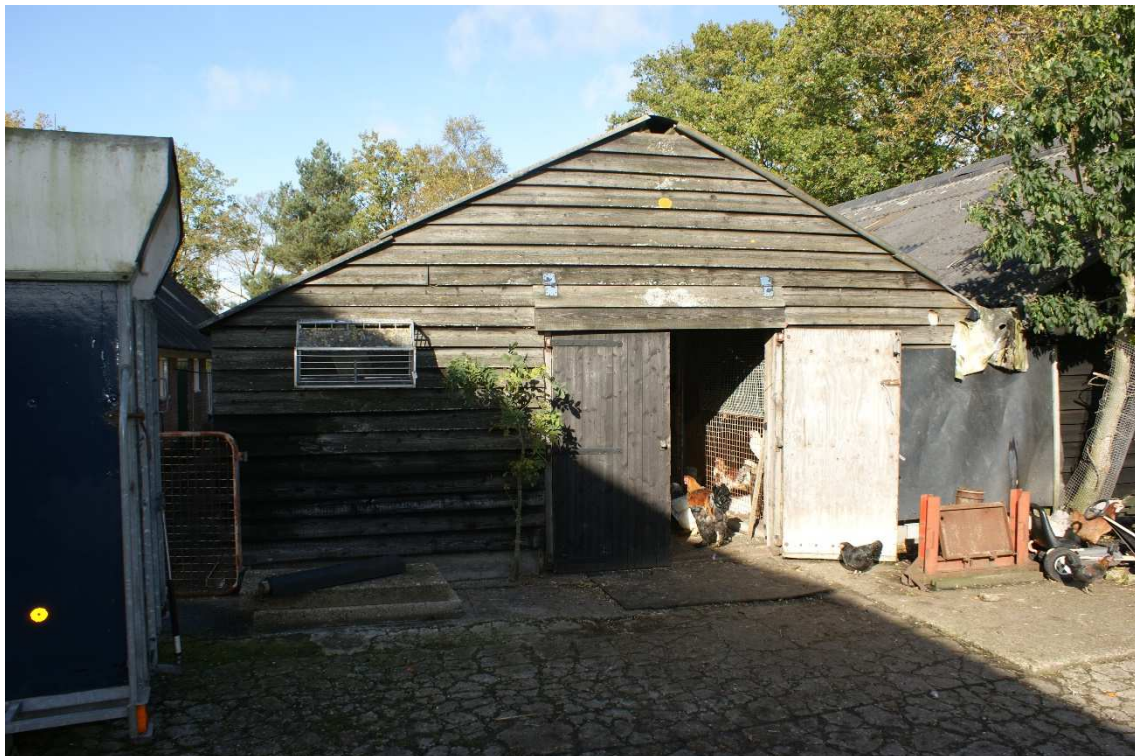
Figuur 2.5 Schuur ten oosten van boerderij (wordt gesloopt)
