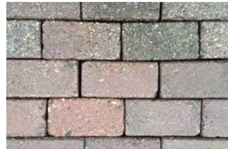
Grindbetonstenen in plaats van betonplaten
