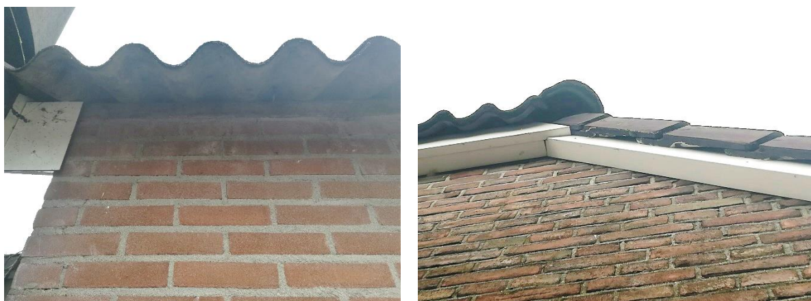
De muurbalk op de spouwmuur van de schuur naast de woning en goed aansluitende windveren en dichtgepurde ruimtes onder de nokpannen van de woning (foto's Laneco).
