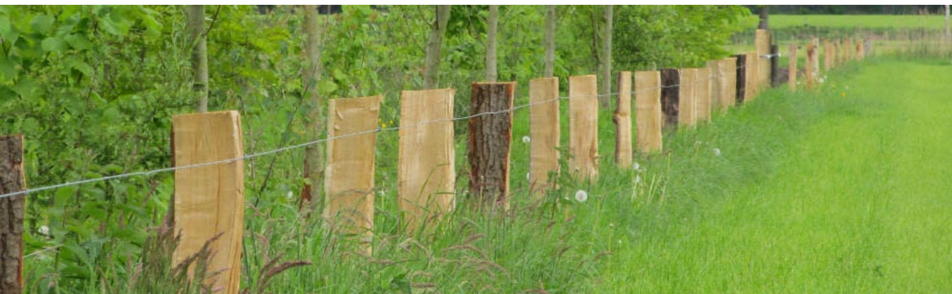
Afbeelding 34. Gekloofde eikenhouten palen voor een robuust en landelijk karakter.
