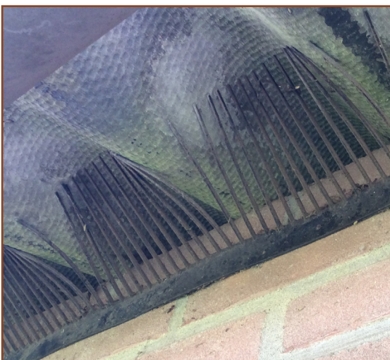
Afb. 3.4: De daken met golfplaten zijn vrijwel allemaal ontoegankelijk gemaakt door middel van vogelschroot.
