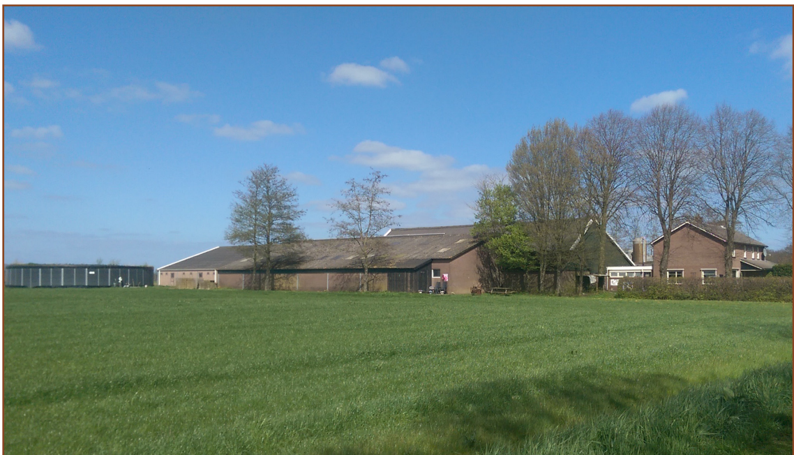
Afb. 1.2: Het onderzoeksgebied gezien vanaf de Hoevendarsweg ten zuidwesten van de locatie. Links de mestsilo, centraal de kapschuur met daarachter een melkveestal en rechts de te handhaven woning.
