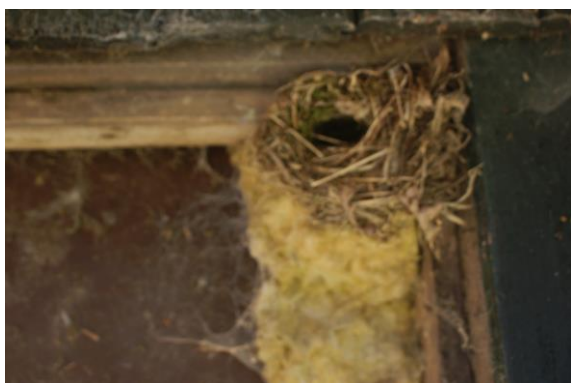
Fig. 5.2.1 Nest middelste schuur
