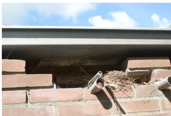
Fig. 5.2.2. Nest zuidelijke schuur
