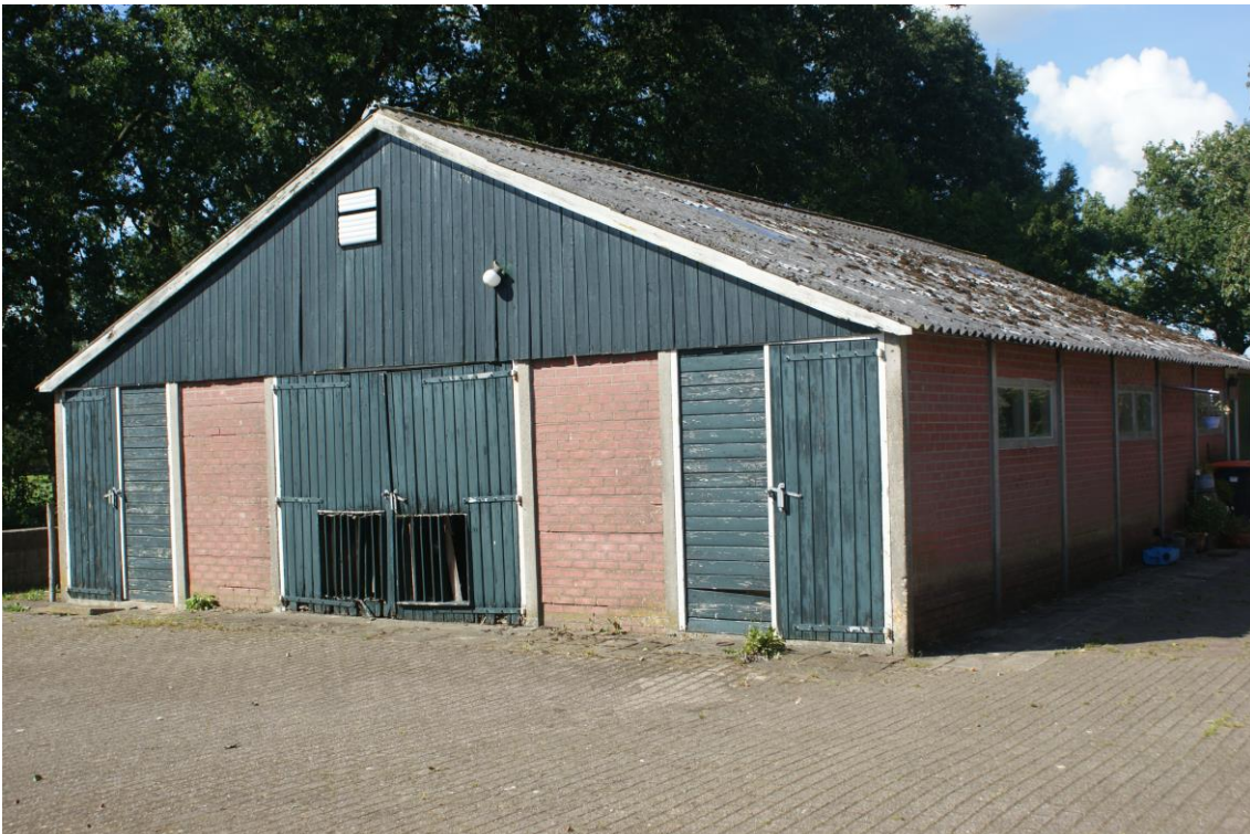
Fig. 2.3 Vooraanzicht te slopen schuur
