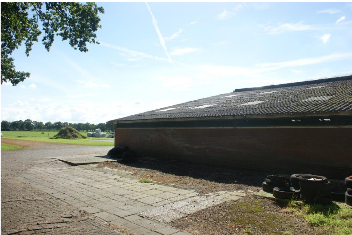
Fig. 2.5 Overzicht erf achter te slopen stal
