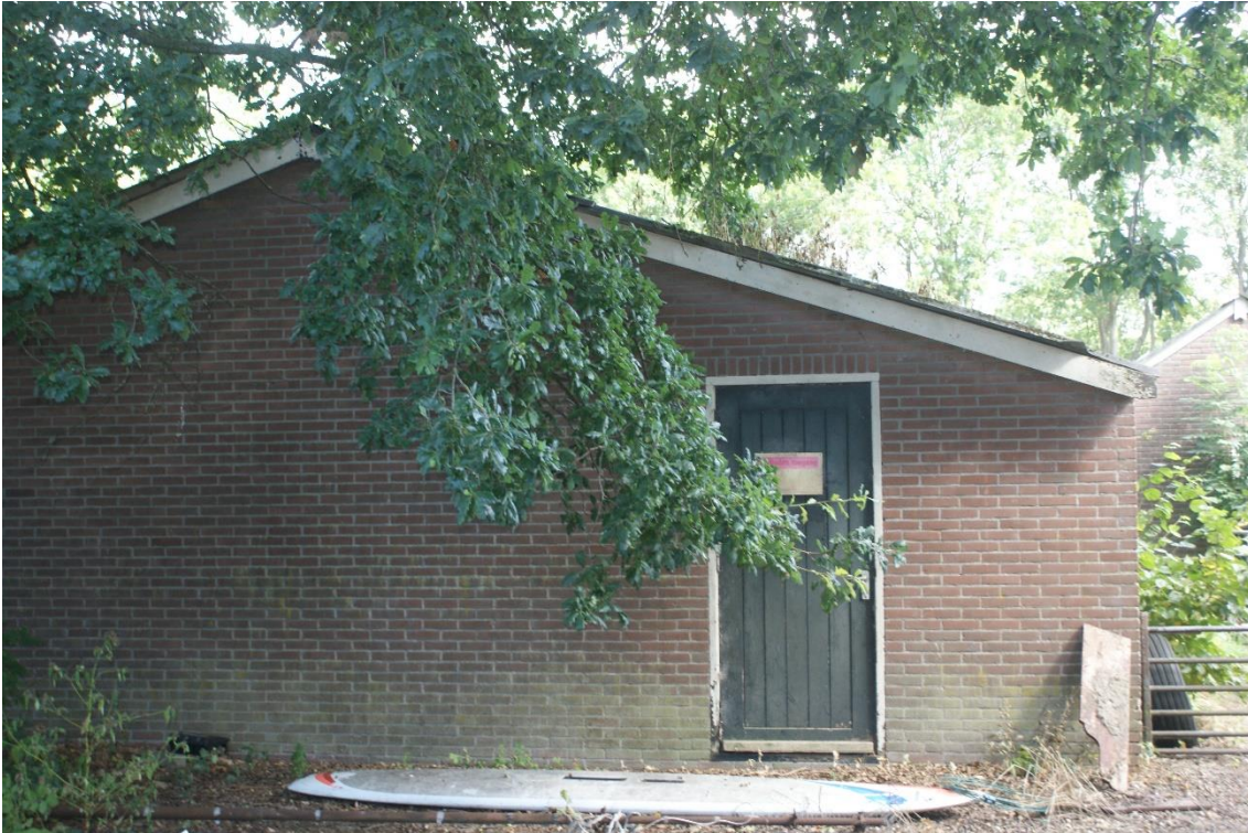
Fig. 2.2 Vooraanzicht te slopen schuur
