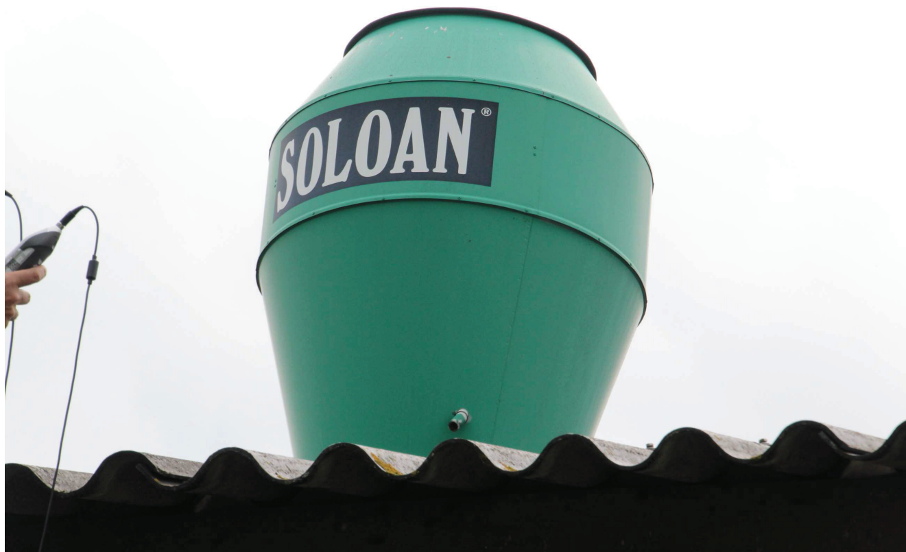
C:\Data\Timmerfabriek Dalfsen\Fotos ██████████ 12-07-2015\002 Luchtafvoerventilator spuitruimte Soloan 12-07-2015.jpg
