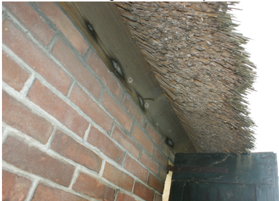
Aansluiting rieten kap op zijmuur
