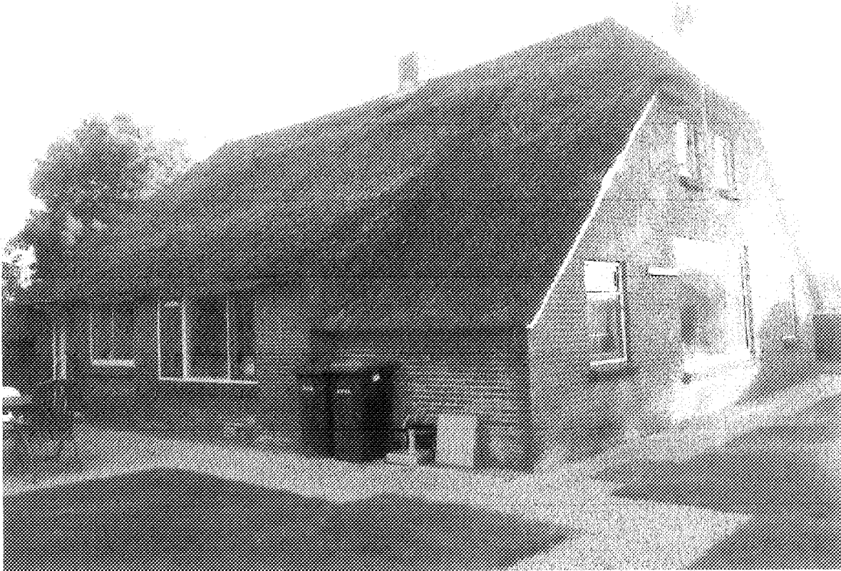
Afbeelding 2 De te slopen gevel (linker deel) en dak. (foto Erwin Goutbeek)
