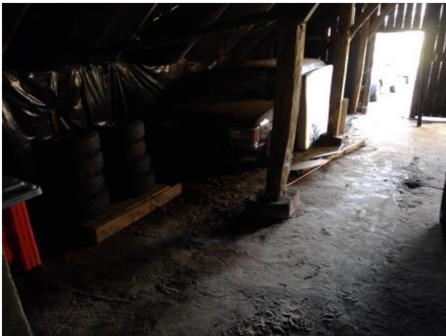
Locatie schuur C, o.a. autostalling
