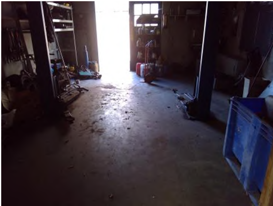
Locatie schuur C met betonvloer
