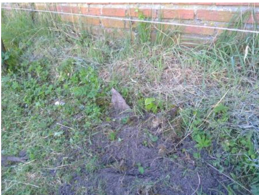
Asbest verdacht materiaal op maaiveld, boring C20
