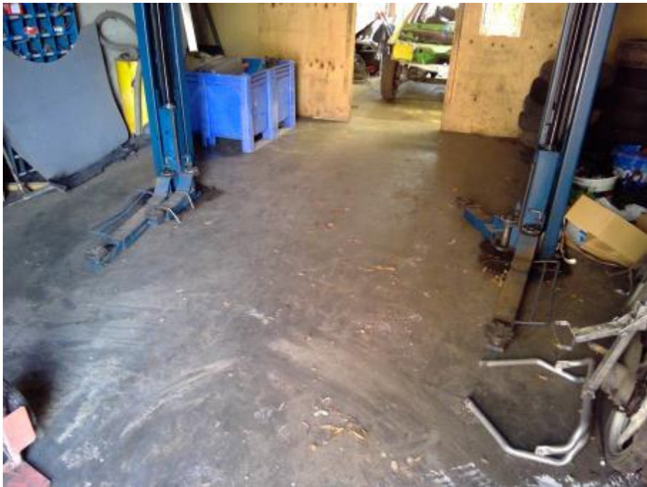
Locatie schuur C, aanbouw met autobrug
