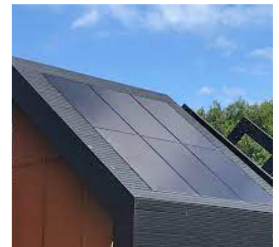
Zonnepanelen geïntegreerd in het dak
