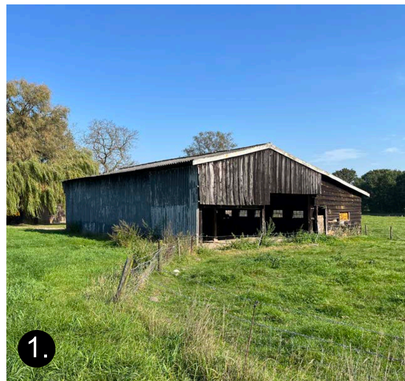
Te slopen houten schuur op erf: 268 m2.
