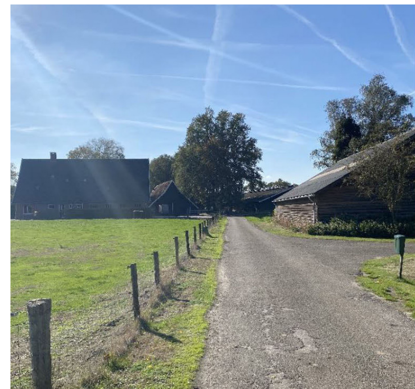
Via de brug Bornsche beek wordt het erf ontsloten. De Bruggemansweg is tot aan het erf verhard met asfalt wordt zandweg.
