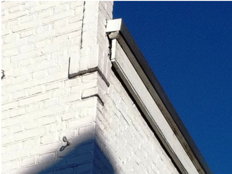
Potentiële verblijfplaats van Gierzwaluw en vleermuizen. Het is onbekend of via deze dekplint ook een eventuele spouw of dakruimte bereikbaar is.
