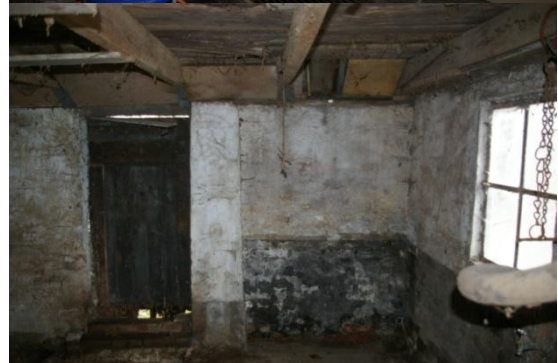
Foto's 5, 6 en 7 binnenzijde van de schuren
