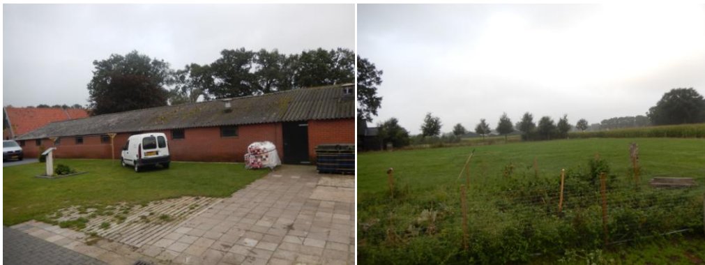
Afbeelding 1 en 2; te verbouwen voormalige varkensschuur, en weiland aan de westkant waar een nieuwe woonkavel gerealiseerd wordt.
