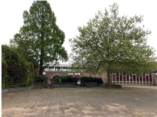
Overzicht schoolplein, achterzijde schoolgebouw
