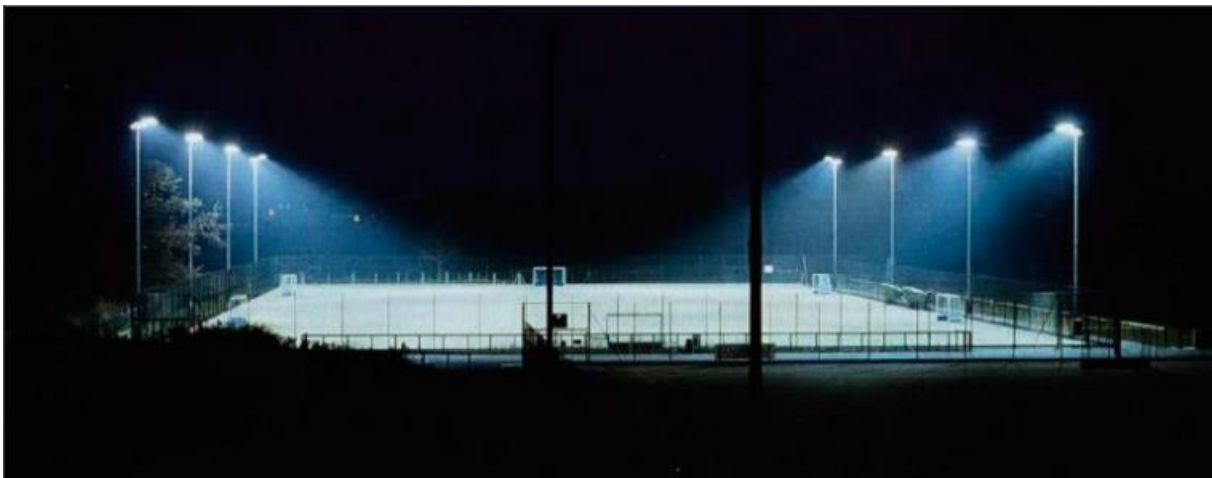
Afbeelding 4: voorbeeld goed afgeschermd verlichting (bron www.nsvv.nl )
