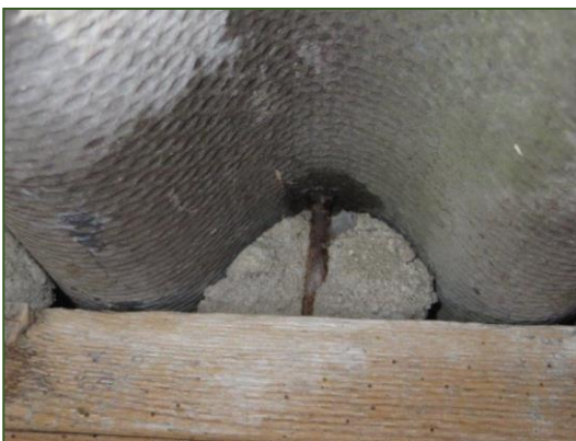
Foto's: Toegang tussen golfplaten en beschot goed afgesloten en ontbreken van beschot bij pannendak.
