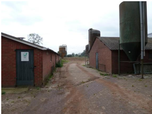
Afbeelding 1: de te slopen varkensschuren
