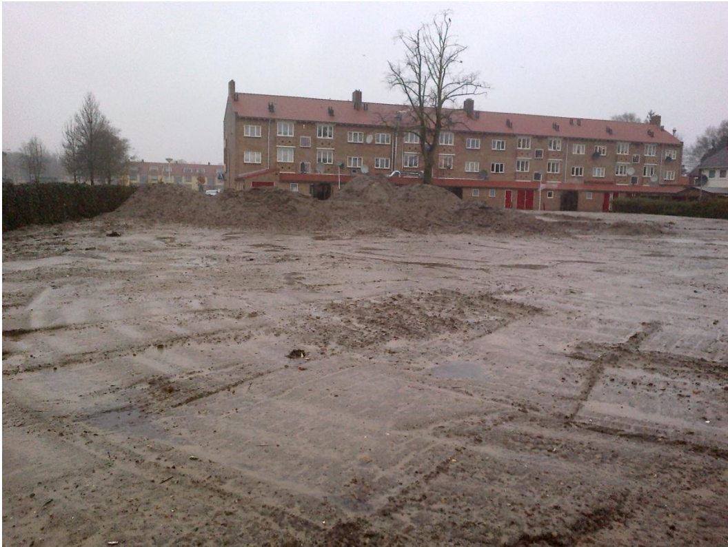
Figuur 5. Overzichtsfoto's van het plangebied in noordwestelijke en oostelijke richting
