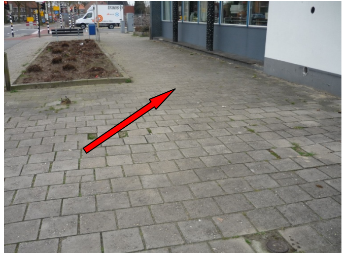
Voormalige ligging HBO- tank
