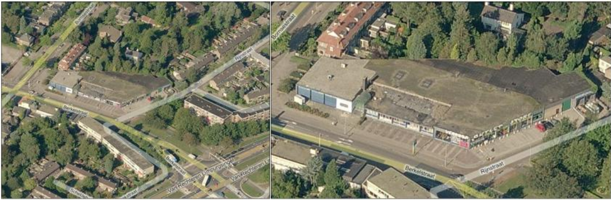
Afbeelding 2.2: Huidige bebouwing in het plangebied (Bron: Bing Maps)
