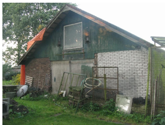
Foto 7: Te slopen enkelsteens bijgebouw
