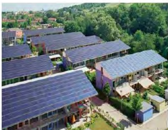
Zonne-energie integraal onderdeel woningen (Solarsiedlung Freiburg Dachaufsicht Dld)
