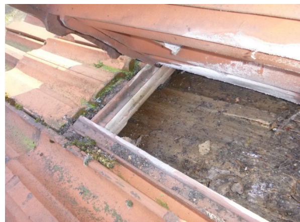
Afdakje met dakpannen en houten dakbeschoot
