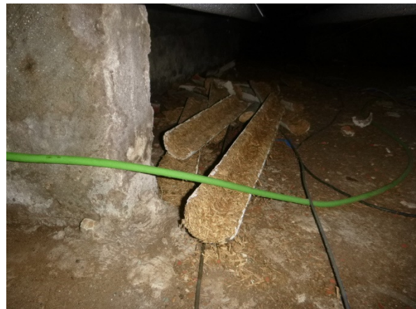
Asbestvrije leidingisolatie kruipruimte
