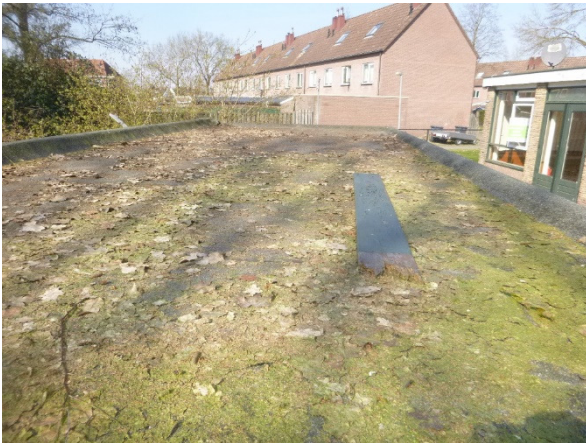
Dakbedekking met steenslag (niet asbestverdacht) op bijgebouw
