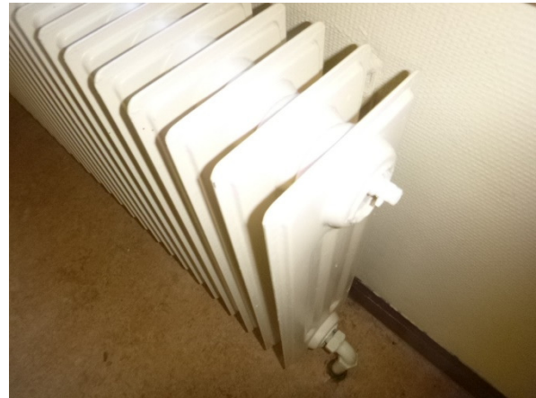
Inspectie verwarming (asbestvrij)
