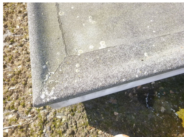
Dakbedekking met steenslag (niet asbestverdacht)
