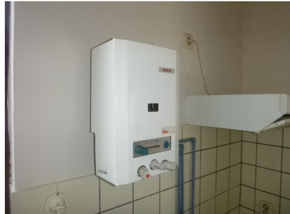
Asbestrijge geiser
