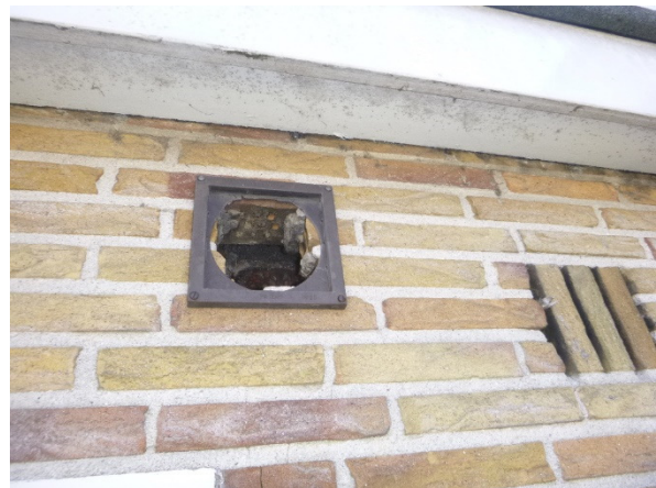
Inspectie ontluchting in muur
