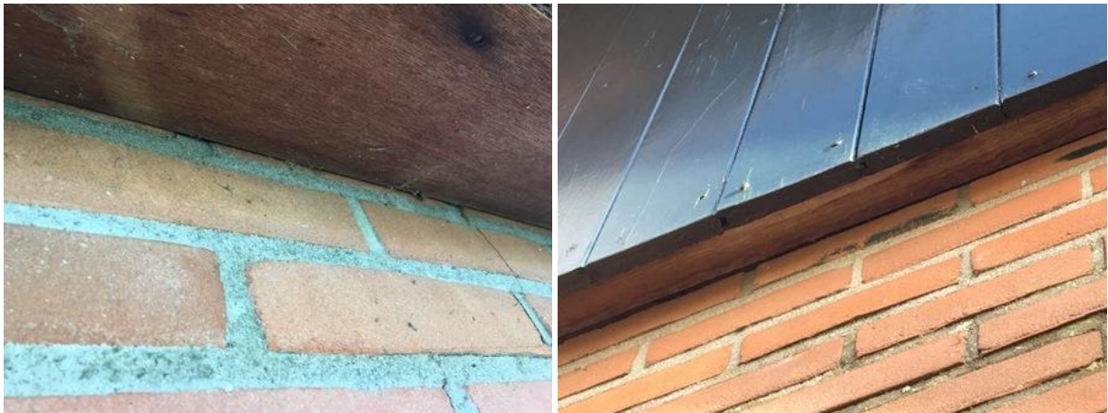
Als gevolg van een strakke afwerking, kunnen vleermuizen geen verblijfplaats bezetten in de te spouw van de te slopen gebouwen.
