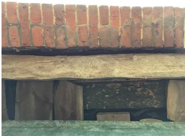
Zicht op de horizontale ligger van het gebintwerk achter de nendeur.
