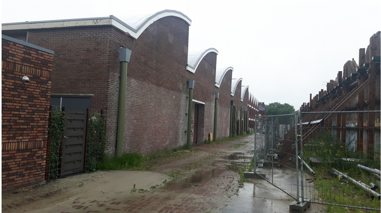
De gebouwen waar de gierzwaluwstenen worden opgehangen.
