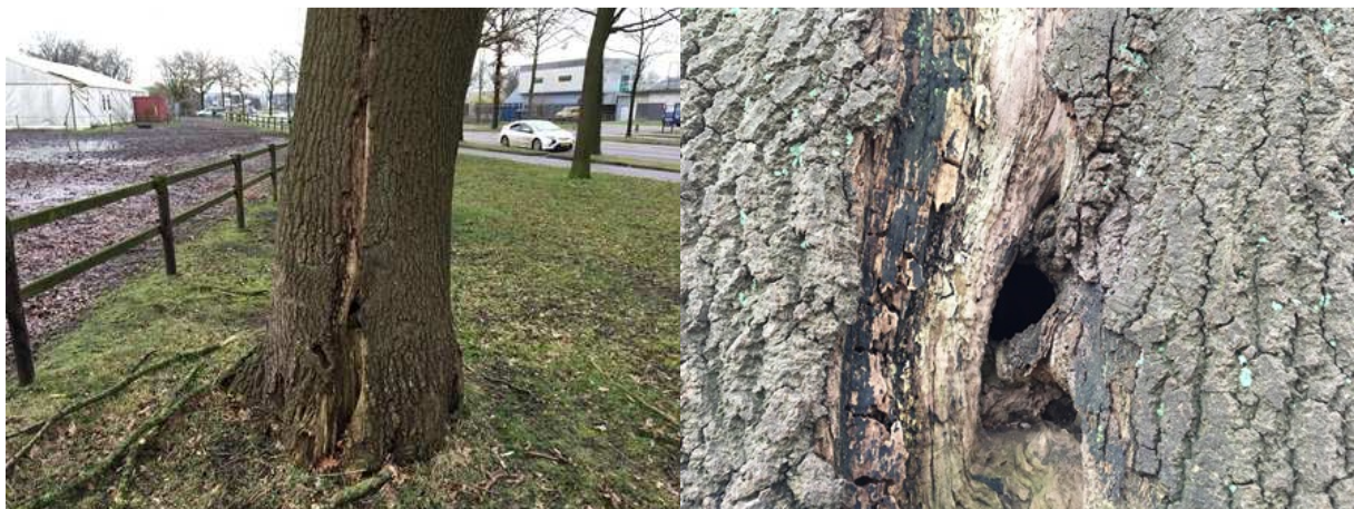
Holte in de 'kauwenboom'. Het gat zit op 75 cm hoogte en vormt daardoor een ongeschikte verblijfplaats voor vleermuizen.
