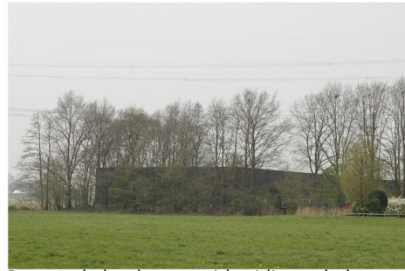
Bestaande loods waar uitbreiding zal plaatsvinden.
