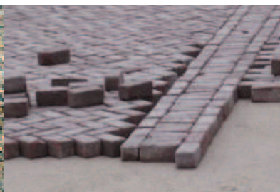
Foto 10. Verbanden aanbrengen
